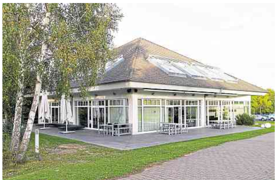
Am Standort Casino wird investiert und neu gebaut.
